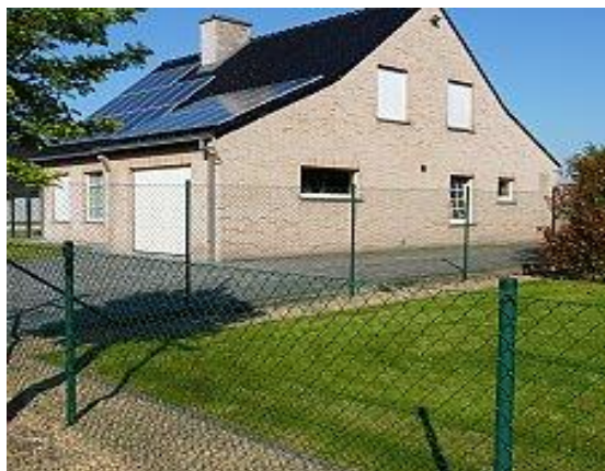
GAASAFSLUITING MET (BETONPLAAT EN) BOVENBUIS
